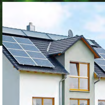
AURINKOSÄHKÖMODUULIT JA INVERTERIT
